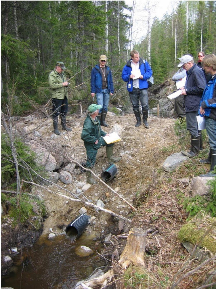
Fig. 2. Peak runoff control dam. Photo: Hannu Hökkä.
