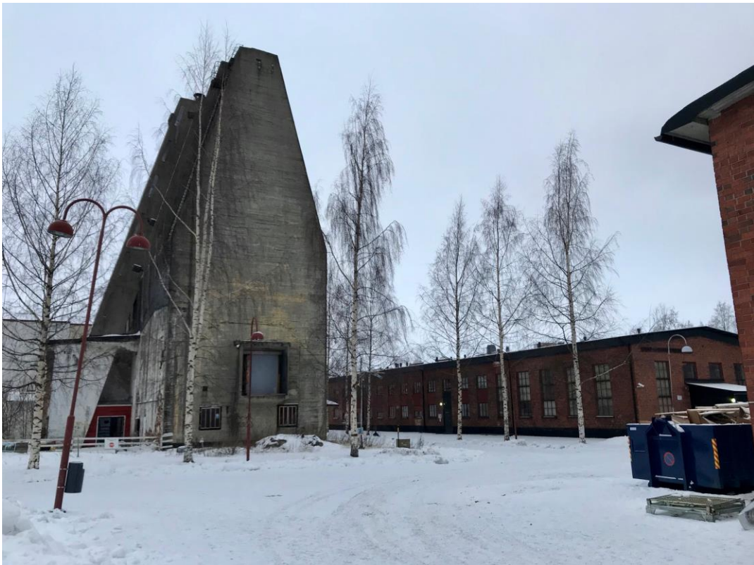
Kuva 2. Alvar Aallon suunnittelema hakesiilo Meri-Toppilassa. (kuva: Joel Vuolle)
