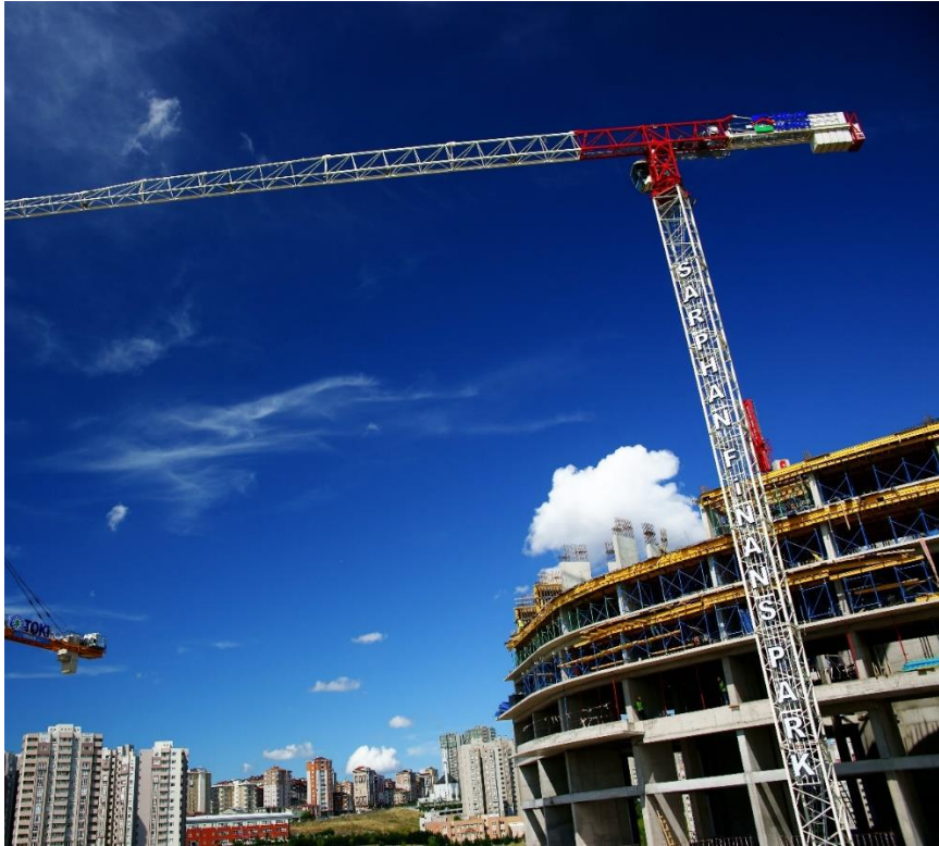
Kuva 3. Huiputon taivutuspuominosturi (Piqsel CC0 2022).
